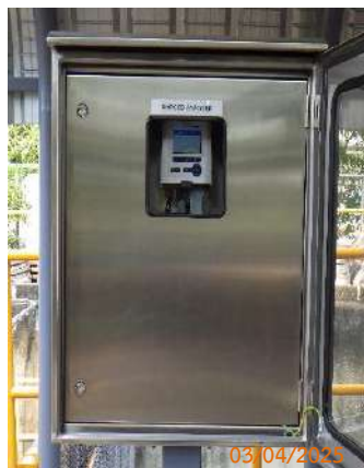
รูปที่ 2-14 เครื่องตรวจวัดคุณภาพน้ำอัตโนมัติ
