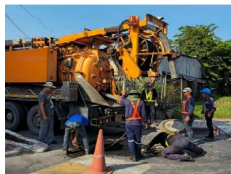
รูปที่ 2-9 ขุดลอกท่อระบายน้ำเสีย
