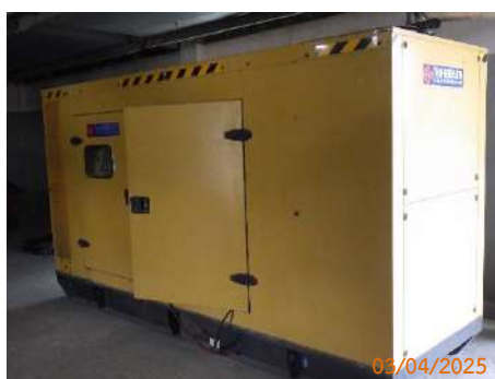
รูปที่ 2-13 ระบบไฟฟ้าสำรองของระบบบำบัดน้ำเสียส่วนกลางของนิคมฯ
