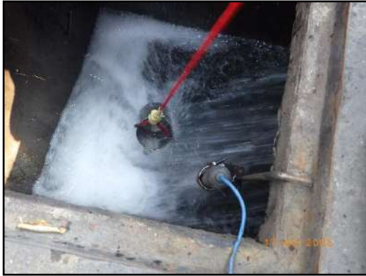
บ่อบำบัดน้ำเสียของโครงการเตาเผา Fluidized Bed ก่อนระบายลงสู่ท่อรวบรวมน้ำเสียของนิคมฯ บางปู รูปที่ 3-6 (ต่อ) จุดติดตามตรวจสอบคุณภาพลักษณะและสมบัติของน้ำเสียเข้าและออกจาก ระบบบำบัดน้ำเสียส่วนกลางของนิคมฯ
