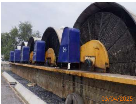
รูปที่ 2-3 ระบบบำบัดน้ำเสียแห่งที่ 2 ชนิด Rotating Biological Contractor (RBC)
