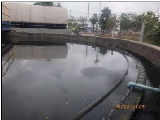
น้ำเสียที่ออกจากถังตกตะกอนของระบบ RBC ในเขตอุตสาหกรรม (พื้นที่โครงการระยะที่ 1) ก่อนระบายลงคลองสลัด
