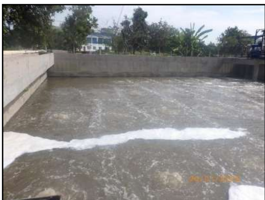
น้ำเสียรวมเข้า Wet Well ของระบบบำบัดน้ำเสียแบบแผ่นจานหมุนชีวภาพ (RBC) ในเขตอุตสาหกรรมส่งออก (พื้นที่โครงการระยะที่ 1)
