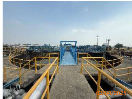
รูปที่ 2-2 ระบบบำบัดน้ำเสียแห่งที่ 1 ชนิด Aerated Lagoon & Activated Sludge
