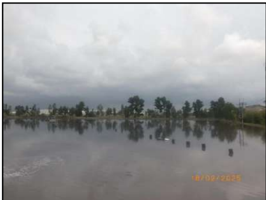
น้ำเสียก่อนเข้าบ่อที่ 1 (บ่อ Aerate Lagoon) ของระบบ Activated Sludge ของเขตอุตสาหกรรมทั่วไป (พื้นที่นิคมฯ ระยะที่ 1)
