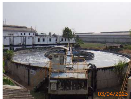
รูปที่ 2-4 ระบบบำบัดน้ำเสียแห่งที่ 3 ชนิด Extended Activated Sludge
