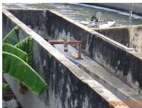
รูปที่ 2-8 อุปกรณ์วัดอัตราการไหลของน้ำเสีย
